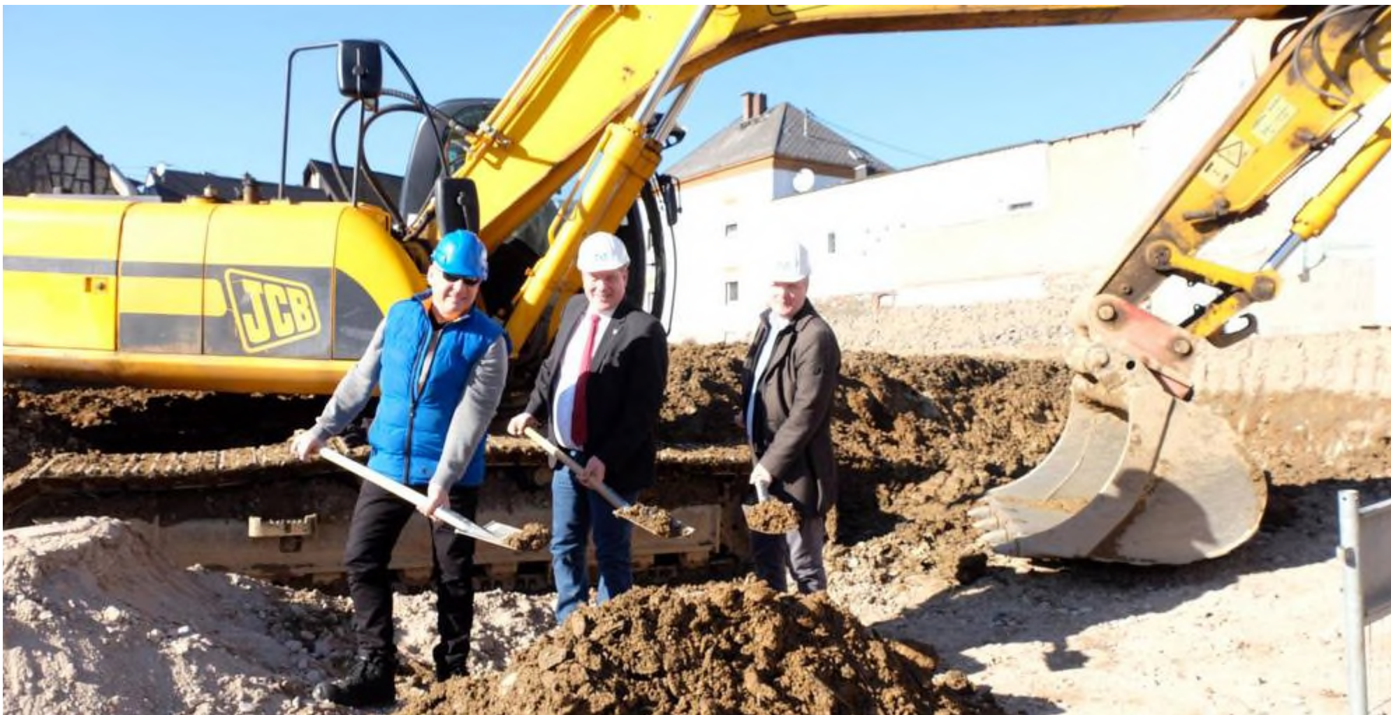
Spatenstich mit Verspätung: Die Bagger arbeiten bereits in Laufenselden.
