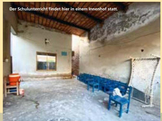
Die sanitären Anlagen sind katastrophal.
